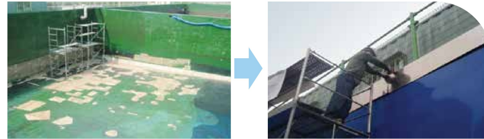
00발전소 폐수조 PE시트 리모델링
