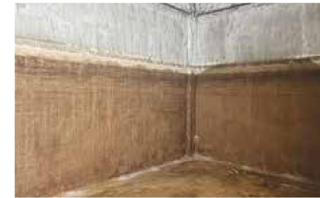
저수조 PE SHEET 시공 (또는 PP SHEET 시공)
