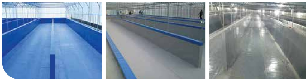
육상 양식장(지붕설치, CON'C 타설후 내부 시트마감)
