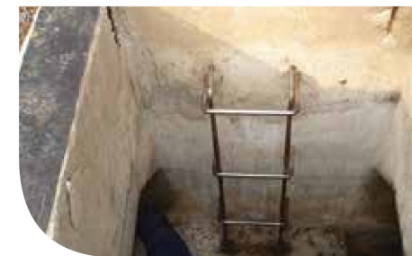
저수조 점검구(맨홀) 시공
